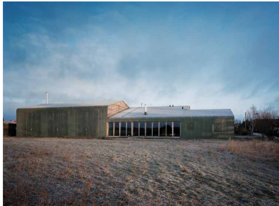
Die ehemalige Schlosserhalle ist in die Landschaft eingebettet / The former locksmith's hall is embedded in the landscape Der dunkle Boden und die dunkle Decke lassen das Holz der Wände leuchten / The dark floor and the dark ceiling make the wood of the walls shine In der Küche umgibt sich Gerhard Schütze nur mit wirklich notwendigen Dingen / The kitchen is equipped only with important things Ein Laubengang verbindet die Gebäudeteile im Außenbereich / A gallery walk connects the building parts from the outside
